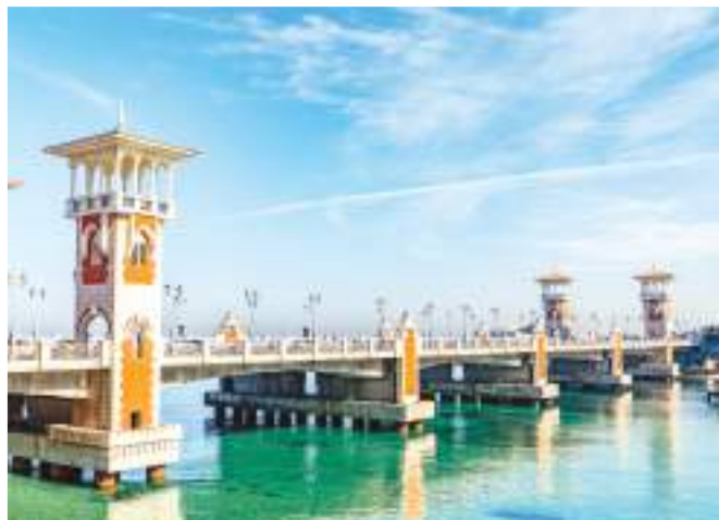
Le pont Stanley est l'un des monuments de la ville d'Alexandrie
